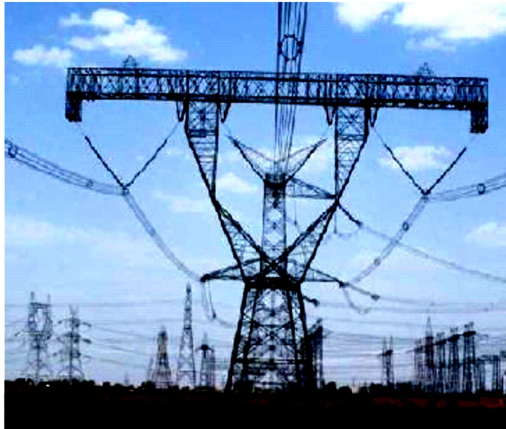
Рис.2. Опытный участок ВЛ 1200 кВ переменного тока (Индия)
