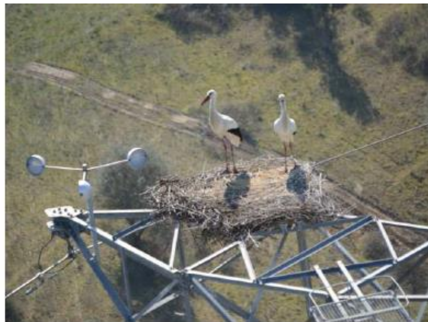
Вращаемое ветром устройство - помеха гнездованию и рядом платформа для формирования гнезда
